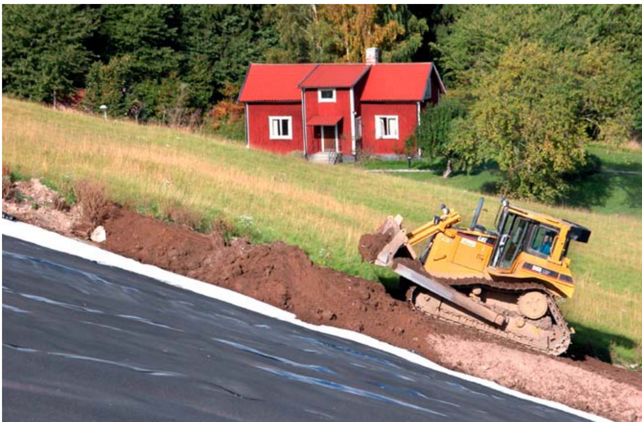
Sluttäckning av deponier är ett ständigt pågående arbete, som leder till minskade utsläpp av metan.
